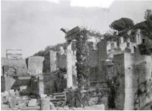
(Foto: E.R. Vin Demati) Boni, 1898: "Preparati di fissare i muri aperti dell'altare del Votivo, intonacati con mortello di mattoni, ed insomma del quale potrà incidere la data della ricomposizione e far rampicarsi qualche rosa o glicinio, piante che Angusto amava"
