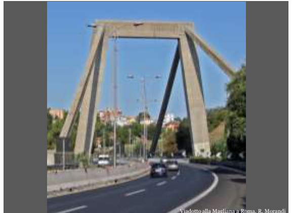
Viadotto alla Magliana a Roma, R. Morandi
