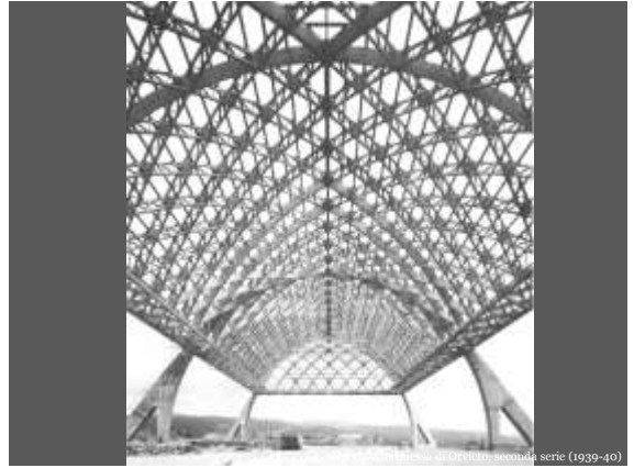
Nervi e Danusso. Aviorimessa in ferro, seconda serie (1939-40)
