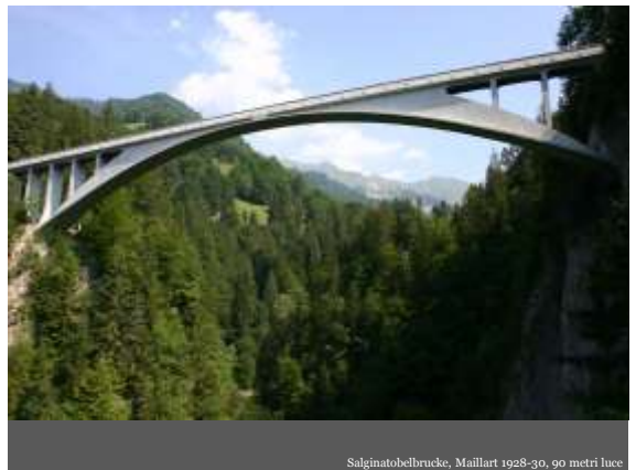
Salginatobelbrücke, Maillart 1928-30, 90 metri luce
