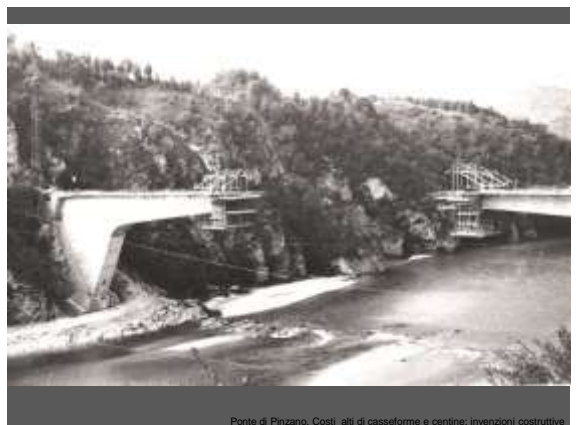
Ponte di Pinzano. Costi alti di casseforme e centine: invenzioni costruttive
