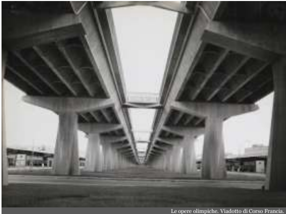
Le opere olimpiche. Viadotto di Corso Francia.
