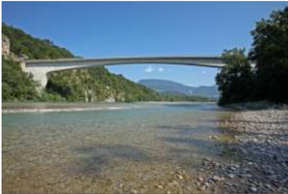
Ponte di Pinzano sul Tagliamento, Zorzi
