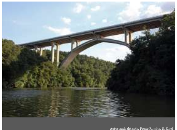
Autostrada del sole. Ponte Romita, S. Zorzi
