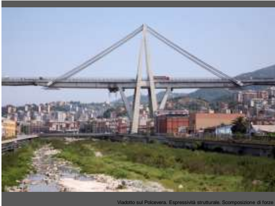
Viadotto sul Polcevera. Espressività strutturale. Scomposizione di forze
