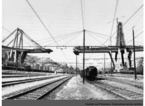
Viadotto sul Polcevera. Costruzione senza centine
