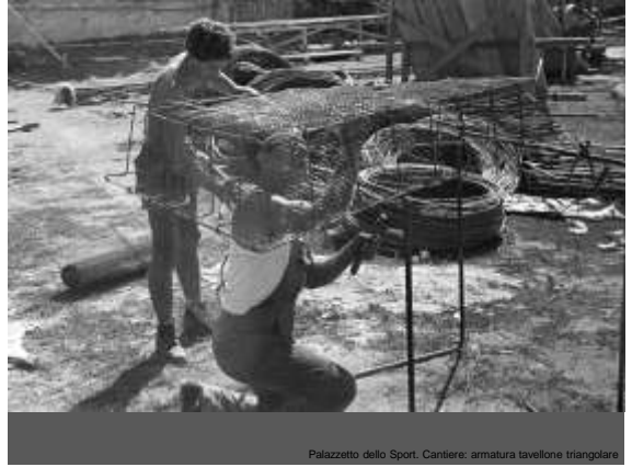
Palazzetto dello Sport. Cantiere: armatura tavellone triangolare
