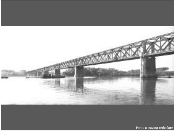
Ponte a travata reticolare
