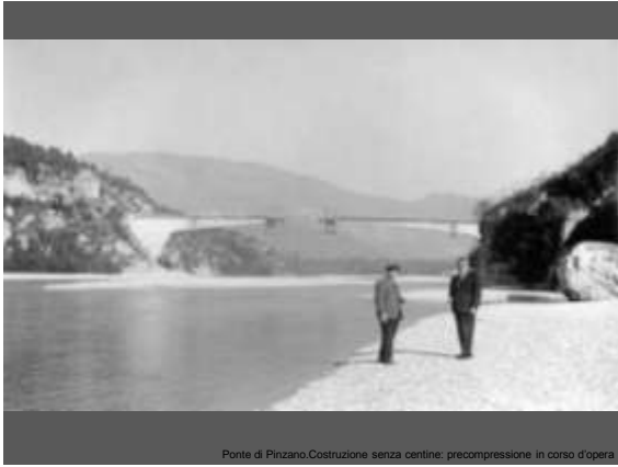
Ponte di Pinzano. Costruzione senza centine, precompressione in corso d'opera.
