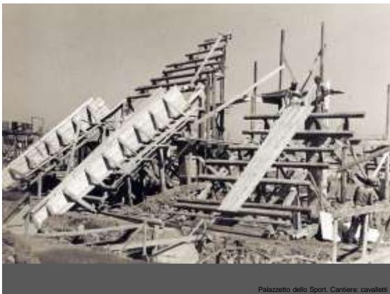
Palazzetto dello Sport. Cantiere: cavalletti
