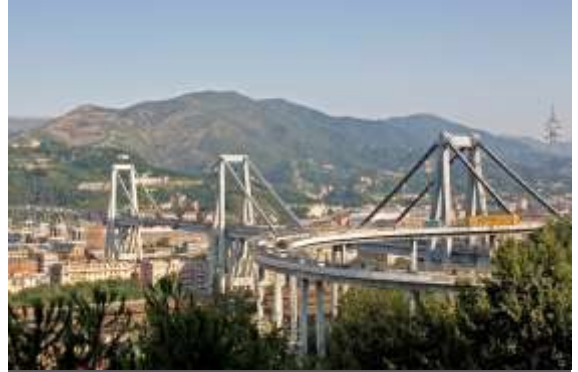
Morandi, Viadotto sul Polcevera, Genova 1960-65
