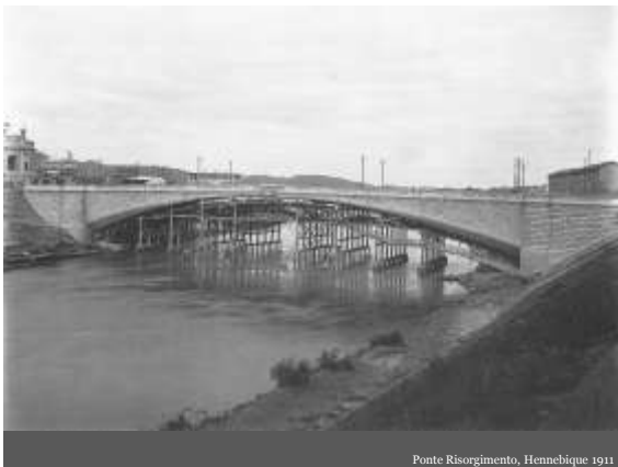
Ponte Risorgimento, Hennebique 1911
