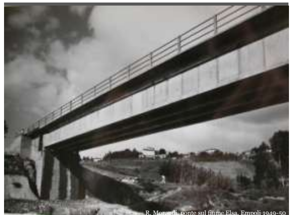
R. Morandi, ponte sul fiume Elsa, Empoli 1949-50
