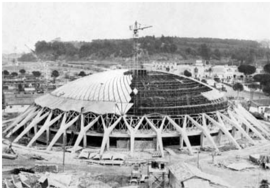
Fig. 1 – Pier Luigi Nervi, Palazzetto dello Sport a Roma, 1956-57 Fig. 2 - Il cantiere di costruzione del Palazzetto dello Sport a Roma, 1956-57
