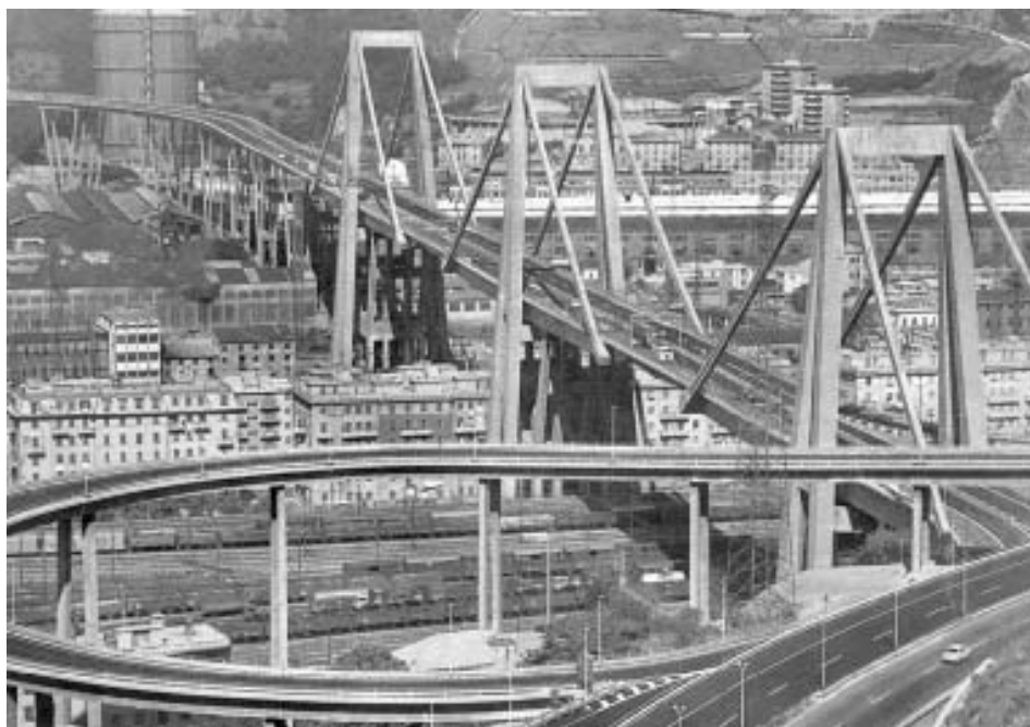
Fig. 3 – Riccardo Morandi, Viadotto sul Polcevera a Genova, 1960-67
