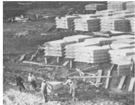
Fig. 2 - Il cantiere di costruzione del Palazzetto dello Sport a Roma, 1956-57
