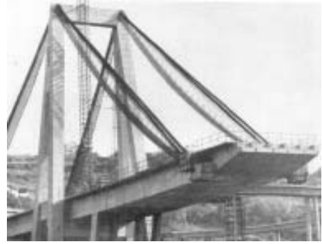
Fig. 4 – Riccardo Morandi, Viadotto sul Polcevera a Genova, 1960-67
