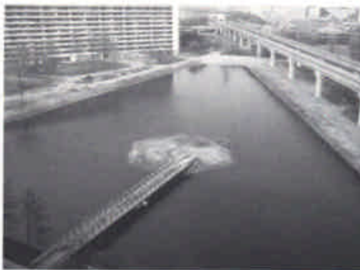
L'estetica della tautologia: un ponte pedonale collega a un'isola esagonale in un lago esagonale circondato da edifici esagonali.
