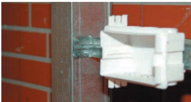
ripristini. I corrugati passano agevolmente tra le asole praticate nei montanti e vengono di tanto in tanto fissati con tamponi di gesso alle lastre o meccanicamente ai montanti. Si devono poi usare idonee scatole portafrutto adatte al fissaggio sulle lastre in gesso rivestito. Per inserire le scatole portafrutto sulle pareti, procedere come di seguito illustrato:
