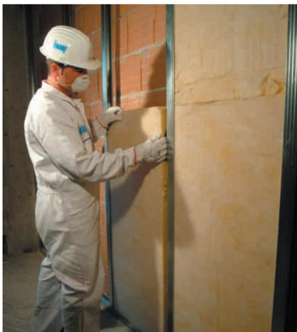
Lane di vetro a bassa densità, ad alta capacità fonoassorbente, incrementano il potere fonoisolante della parete.
