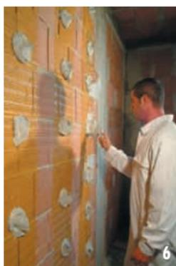
Controllare che i mucchietti siano posti ad interasse pari a 40 cm in senso trasversale e 45 cm in senso longitudinale.
