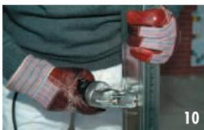
Regolare la distanza dei montanti dalla parete retrostante così da permettere l'inserimento nell'intercapedine del materiale isolante ed agevolare il passaggio degli impianti. Verificare la verticalità dei montanti ed avvitarli alle guide. Per contropareti alte i profili "C Plus" possono essere prolungati con l'apposito giunto lineare.
