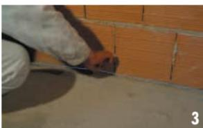
Applicare il **nastro mono/biadesivo di guarnizione isolante** in polietilene espanso sull'anima della guida, per contenere le trasmissioni acustiche laterali. Fissare la guida inferiore con fissaggi ad interasse 50 cm.
