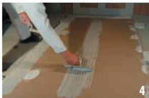
Per l'incollaggio di lastre di spessore 9,5 mm e Isolastre LM/PSE/XPS + 9,5 mm applicare due ulteriori strisce adesive longitudinali al centro.
