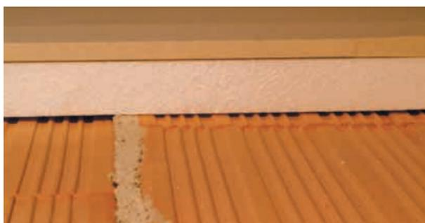
L'applicazione delle lastre conferisce alle superfici murarie un miglior aspetto estetico e permette l'occultamento di impianti. Le operazioni prevedono l'incollaggio diretto delle lastre sul supporto mediante apposite malte a base di gesso.
