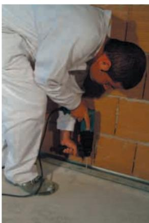
La costruzione di una controparete in gesso rivestito comincia dal tracciamento della posizione delle guide a "U" a pavimento. Determinato lo spessore finale della parete, tracciare la posizione della guida a pavimento e poi riportarla,
