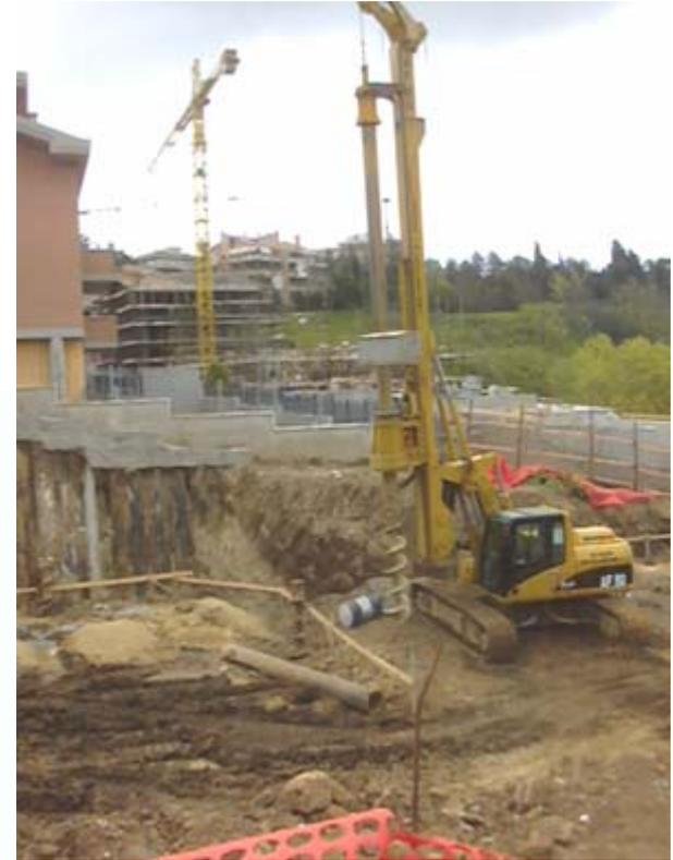
PALO TRIVELLATO SENZA TUBO DI RIVESTIMENTO PROVVISORIO IN PRESENZA O NON DI FANGHI BENTONITICI
