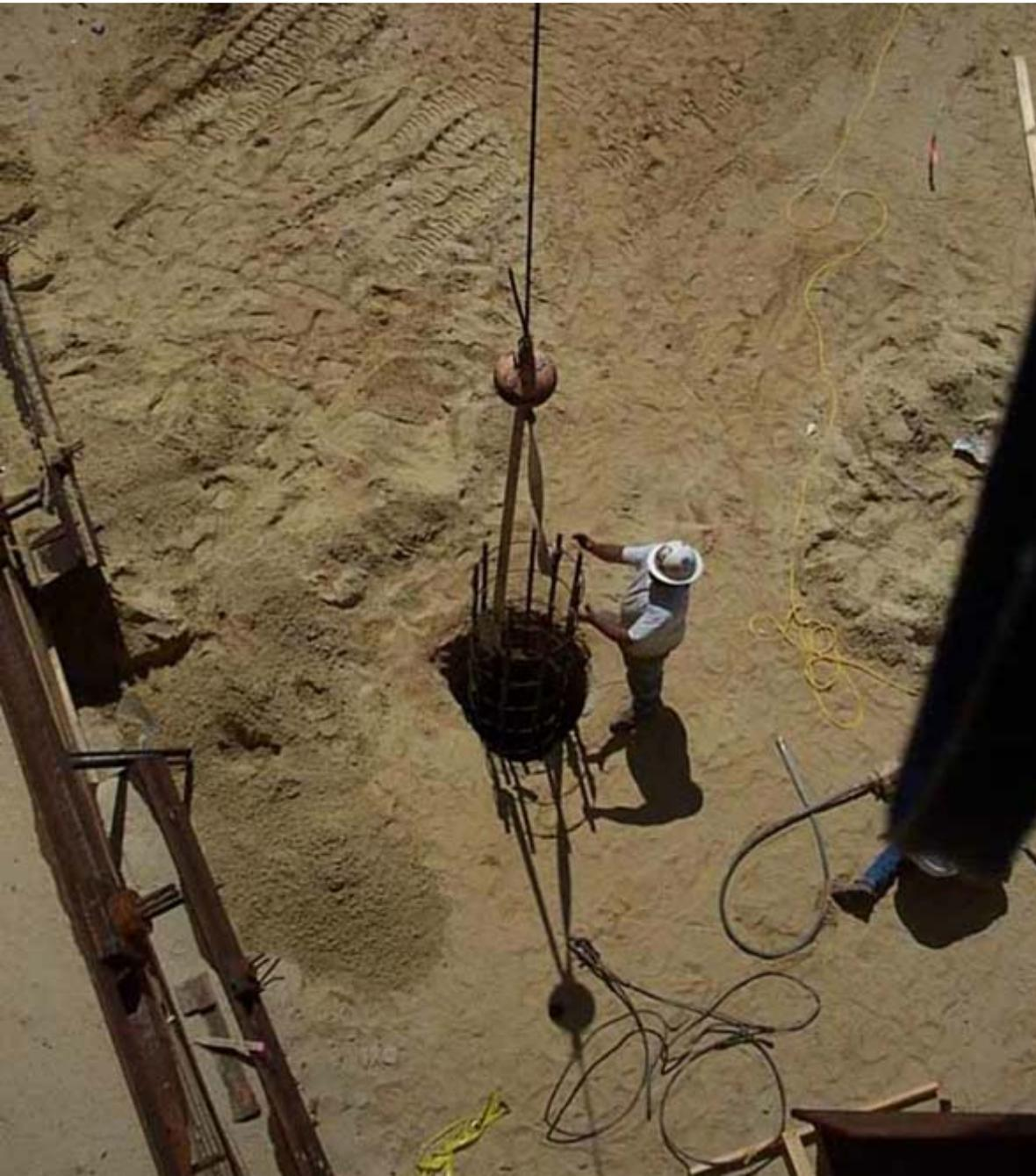
**Realizzato il foro nel terreno si cala l'armatura del palo**
