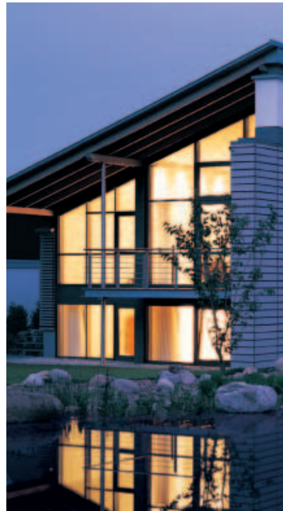
Abitazione privata, Ahaus Germania Private home, Ahaus Germany
