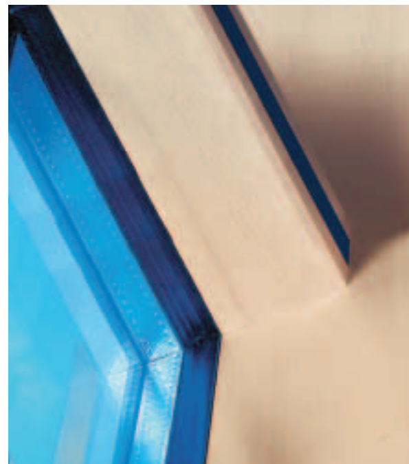
FW 50+ riportata su sottostruttura in legno FW 50+ timber add-on construction
