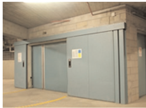
Fig. E.5.2 - Esempi di compartimentazione con porta REI.
