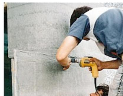
**COMPOSIZIONE:** Pannello realizzato con un nucleo di cemento Portland con aggiunta di polimeri e rinforzato con rete di fibra resistente ai prodotti alcalini
