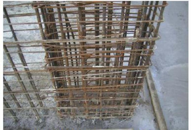
**Dettagli armatura nello spigolo**
