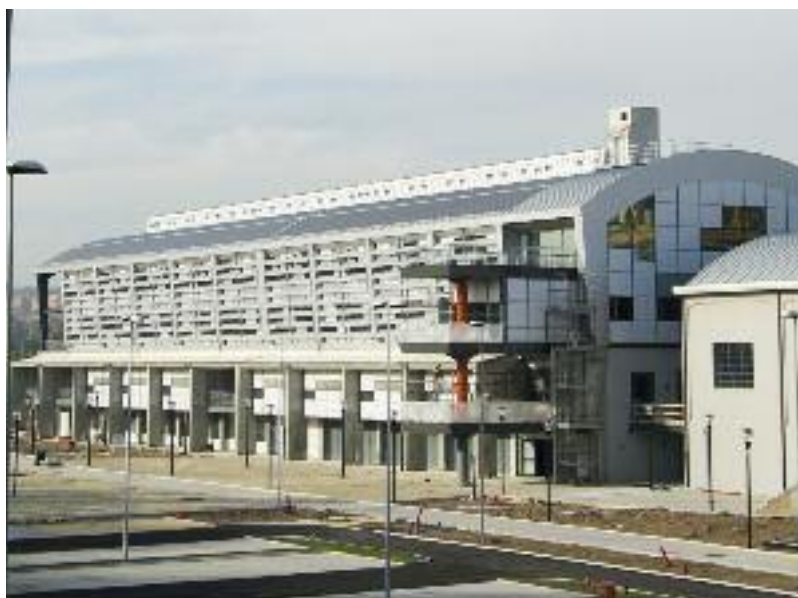
Ex Vasca Navale, vista d'insieme lato Sud
