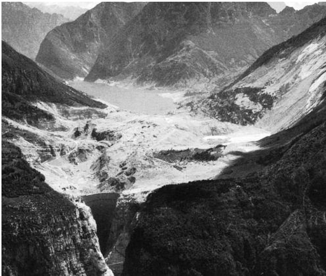
Panoramica della Valle del Vajont poco dopo il disastro del 9 ottobre 1963. È ben visibile la frana di 260 milioni di metri cubi staccatasi dal Monte Toc e precipitata nel bacino artificiale
