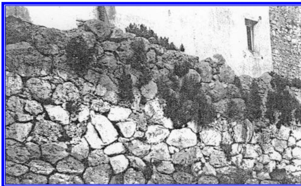
**Fig. 1 - Esempi dell' opera poligonale della prima maniera**
