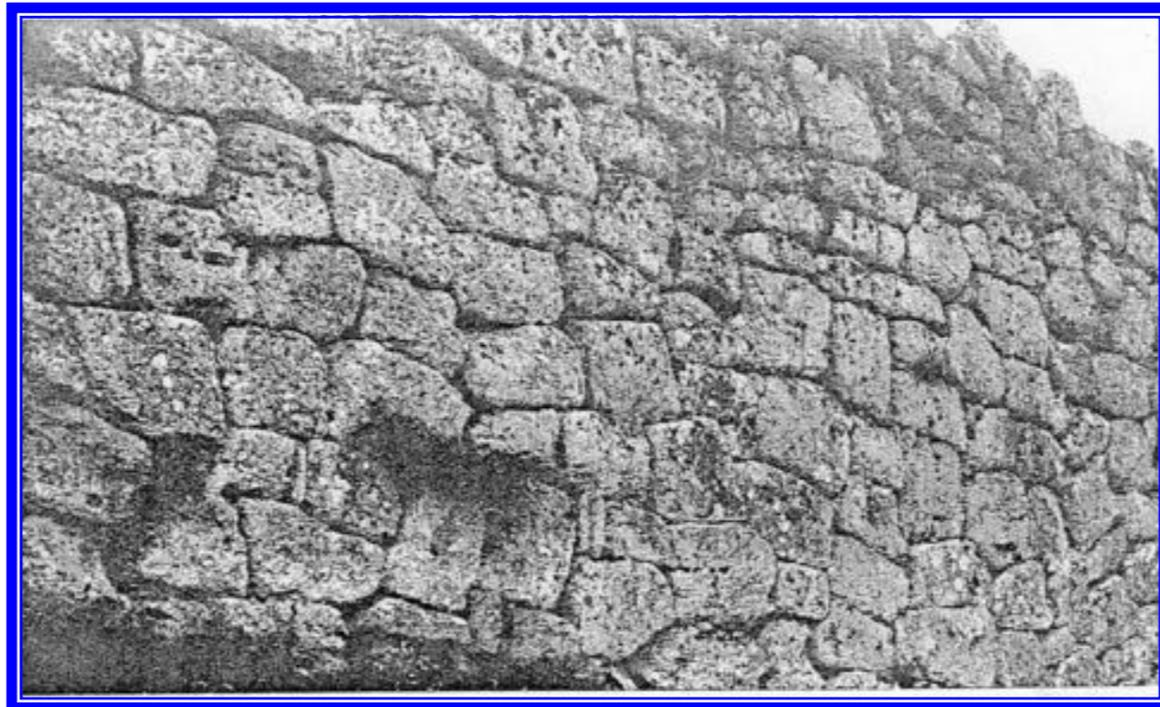
**Fig. 5 - Esempi di opera poligonale della seconda maniera**
