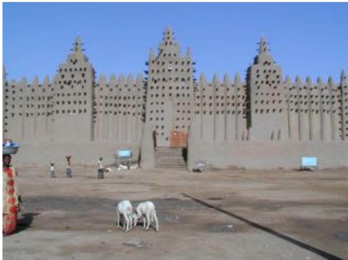
Per elevare un muro in mattoni crudi viene usata come legante una malta d'argilla o una malta di calce e il muro a sua volta, deve essere protetto dall'umidità ascendente, tramite una barriera orizzontale e, verticalmente dalla pioggia, tramite un intonaco a calce.
