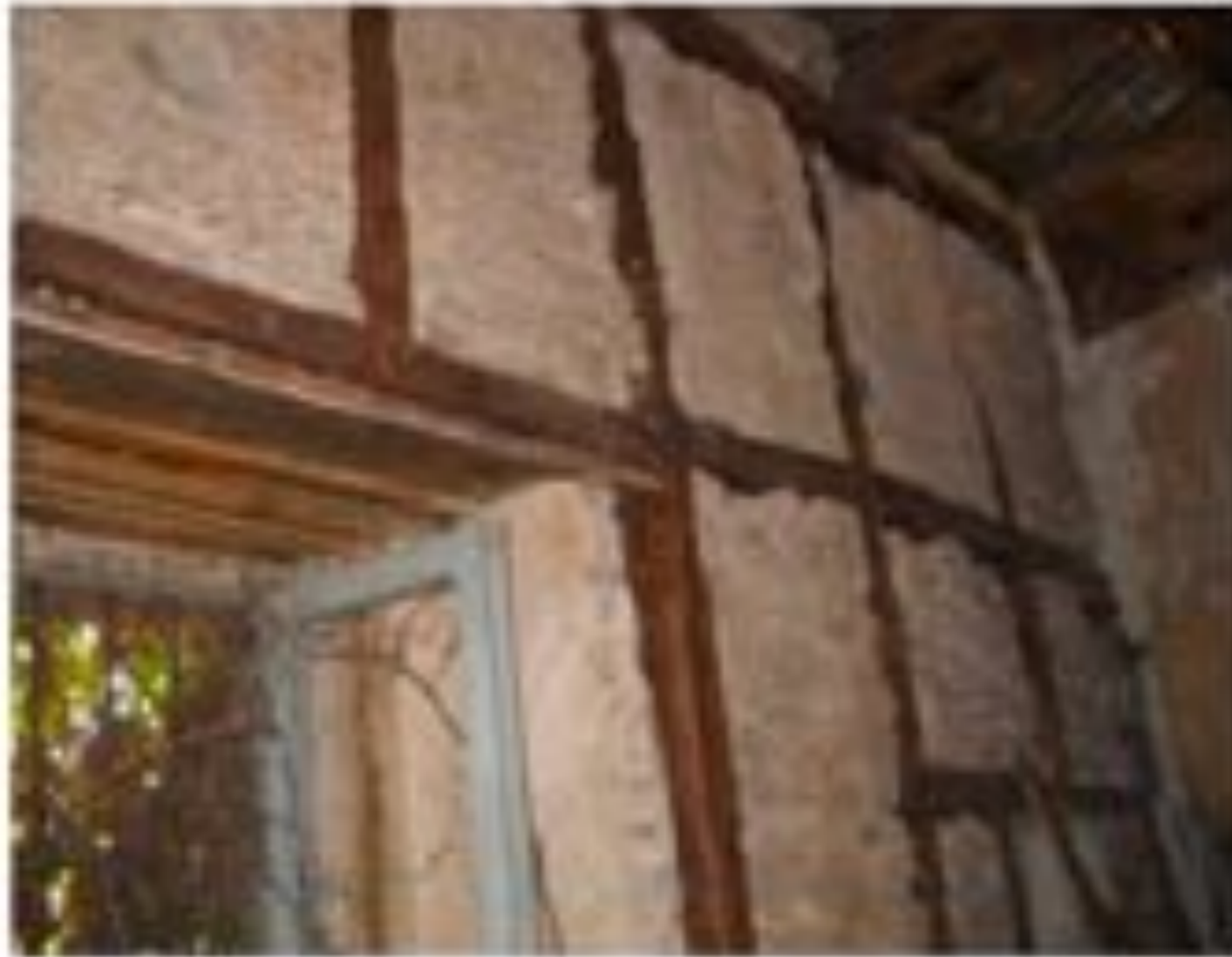
Fig. 4 Mileto (Vv), Palazzo Vescovile, Particolare dell'intelaiatura lignea.
